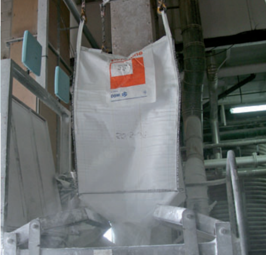
Zwei Antennen Simatic RF660A oberhalb der Materialzuführung (links) erfassen die Signale der Smart Labels RF620L auf den Bigbags
